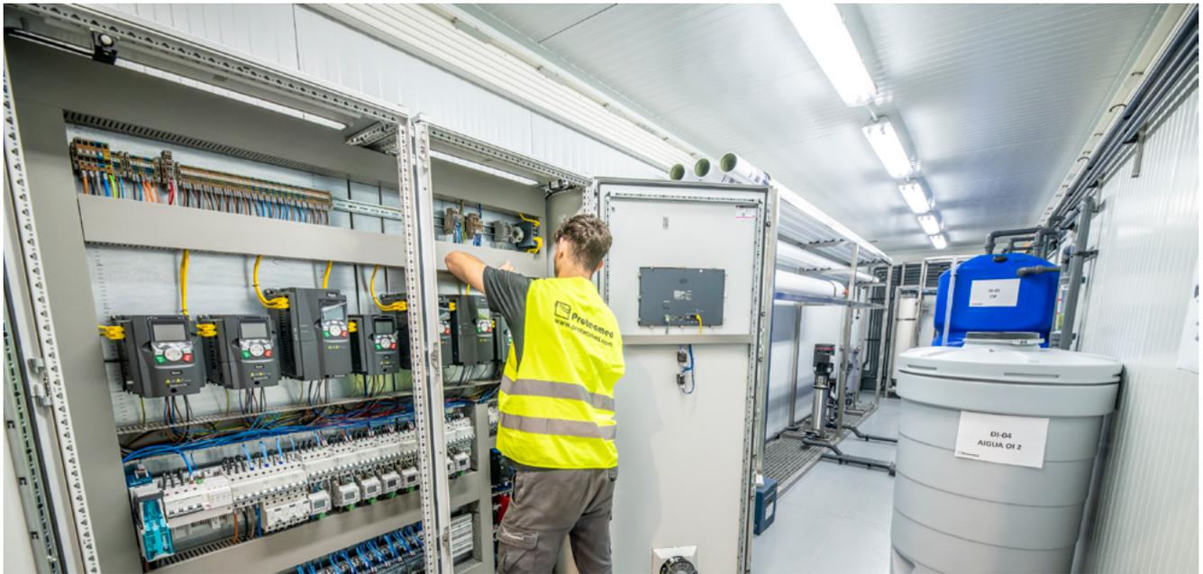
*Un operario pone a punto la planta piloto para la purificación del agua de la estación depuradora de aguas de Roses, que cuenta con seis procesos distintos para garantizar la eliminación de los posibles contaminantes y los agentes patógenos.*
