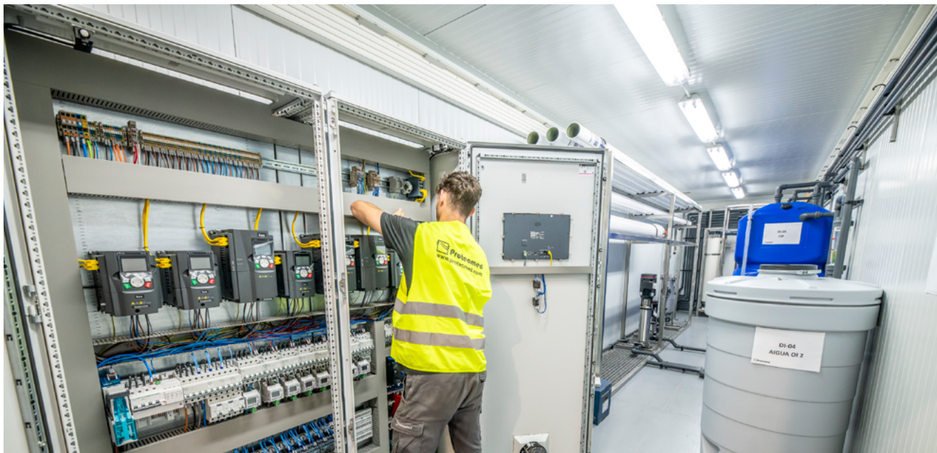
Un operari posa a punt la planta pilot per a la purificació de l'aigua de l'Estació Depuradora d'Aigua de Roses, que compta amb sis processos diferents per assegurar l'eliminació dels possibles contaminants i els agents patògens.
